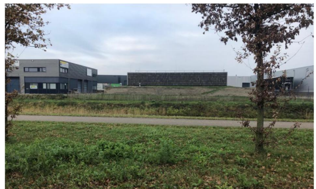
Foto schakelstation op De Laarberg
